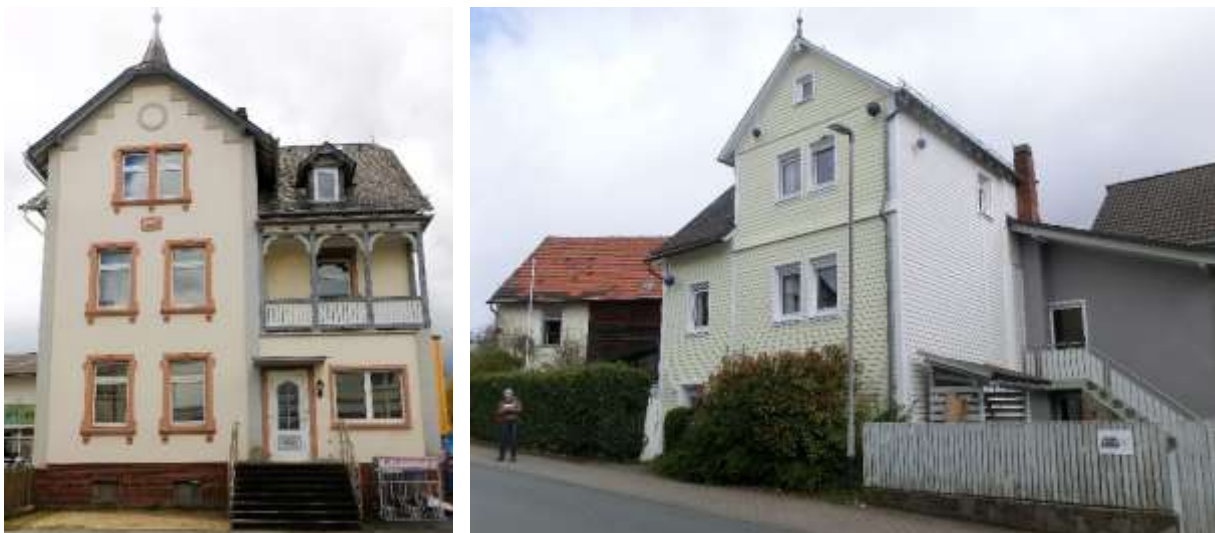
Abb. 22: links: Repräsentatives, im Jahr 1905 erbautes Wohnhaus in der Bahnhofstraße; rechts: Weiteres Wohnhaus aus der Jahrhundertwende als modern umgebautes Wohnhaus mit gut erhaltenem Scheunengebäude in der Usinger Straße
