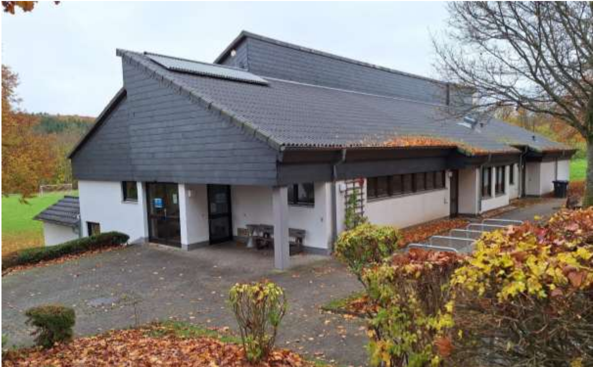
Abb. 54: Holzbachtalhalle in Friedrichsthal (Baujahr 1984)
