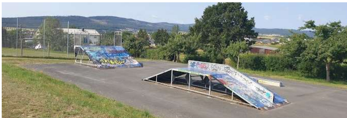
Abb. 62: Stark modernisierungsbedürftige Skateanlage in Wehrheim
