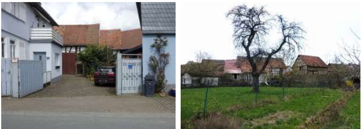
Abb. 37: Vergleich von Bebauung mit Scheunenkrantz in der Schillerstraße: linkes Foto zeigt die straßenseitige dichte Bebauung ohne Grünflächen auf dem Grundstück; rechtes Foto zeigt den rückwertigen Blick auf den Scheunenkrantz mit dahinter großzügig angelegten Bauerngärten und privaten Freiflächen
