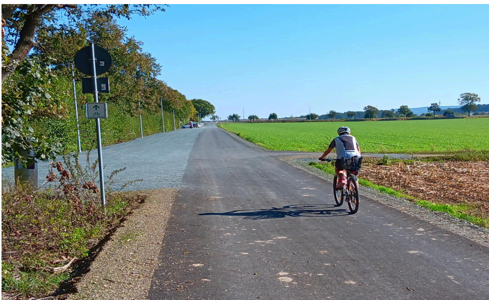
Abschnittsweise wird die Oberlohspange zwischen Kreuzstein und Umgehungsstraße erneuert
